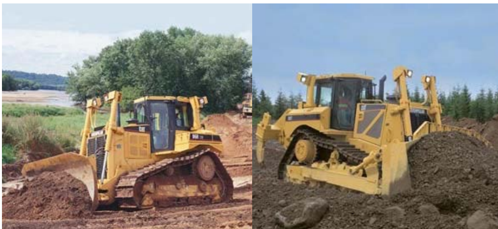
بولدوزر در حین عملیات خاکی
